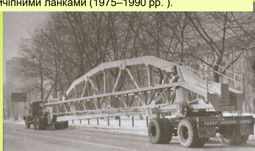
Напівпричіп-фермовоз УПФ 18/24 для перевезення будівельних конструкцій довжиною 18 та 24 м
