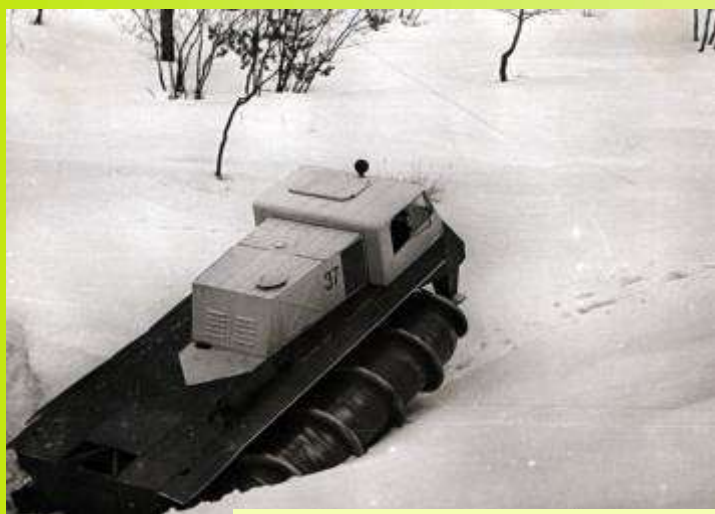
Випробування шнекохода на снігу
