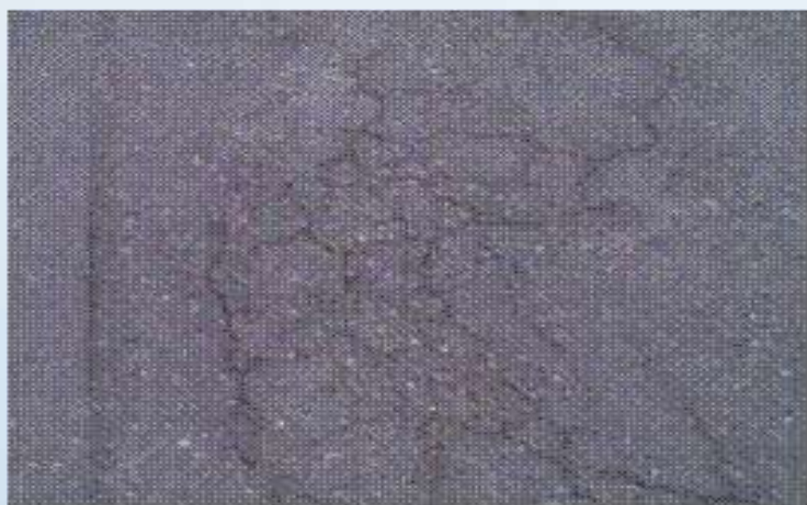
Підповерхневі неоднорідності тонкошарового асфальтобетону
