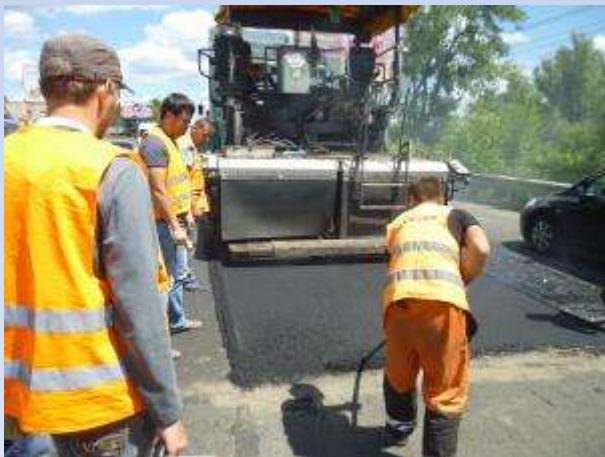
Науковий супровід при влаштуванні асфальтобетонного покриття
